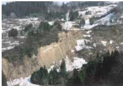
写真3-106 崩落的地すべりでできた断層面
